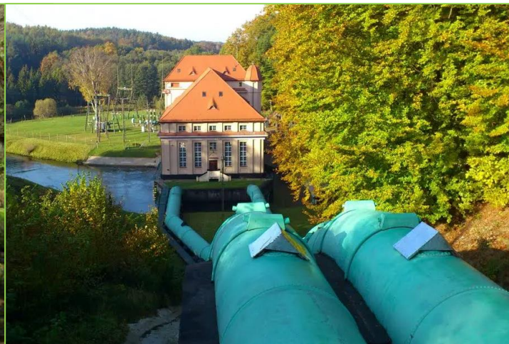
Elektrownia wodna w Gałąźni Małej
